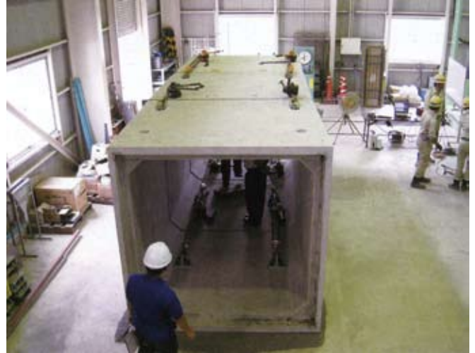
曲線施工試験 (IB50タイプ)
