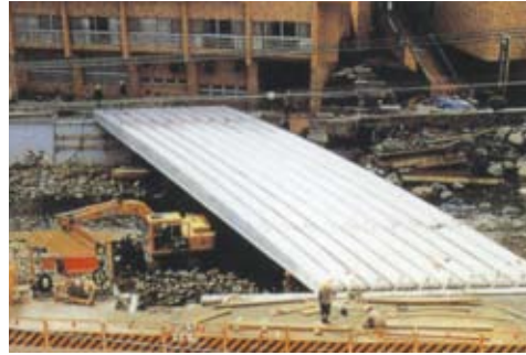
接合工、緊張作業
