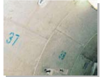
P&PCセグメント (継手金物がない)
