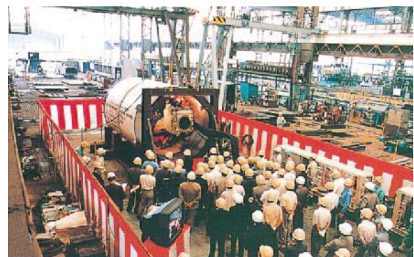
シールド機内でのPC鋼材の挿入・緊張・定着の作業性やボルトレスによる組立施工性・精度を確認
