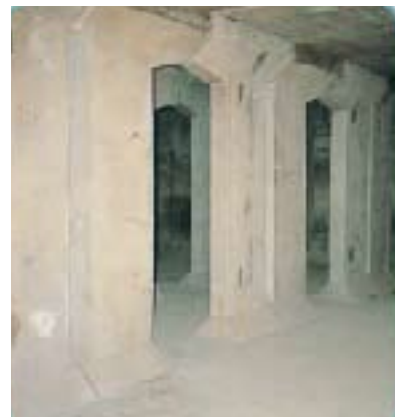
5 底版部打設完了
