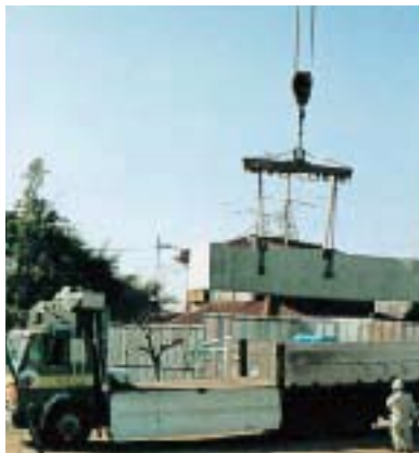
1 トラックより吊り降ろし
