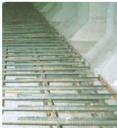
5 底版部配筋状態
