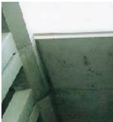
7 頂版部蓋掛状態
