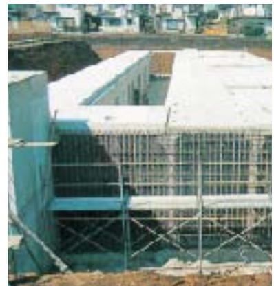
9 端壁(配筋状態)
