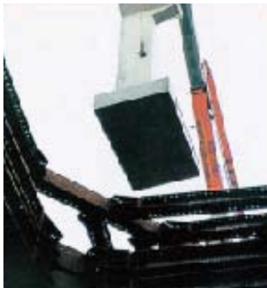
4 基礎上へ吊り降ろし
