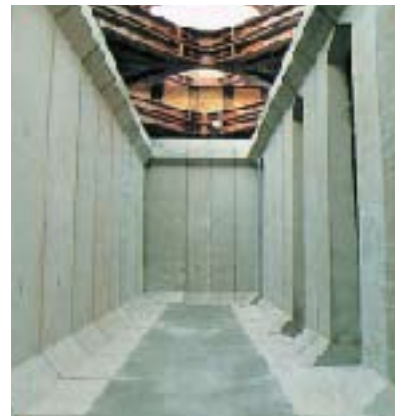
9 底板部打設完了
