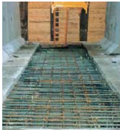
8 底板部配筋状態
