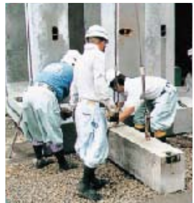
3 浸透貯留施設据付状態
