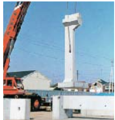
3 吊り上げ状態
