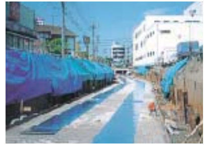
3 滑走面養生工
