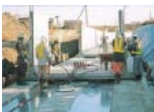
U型水路の施工
