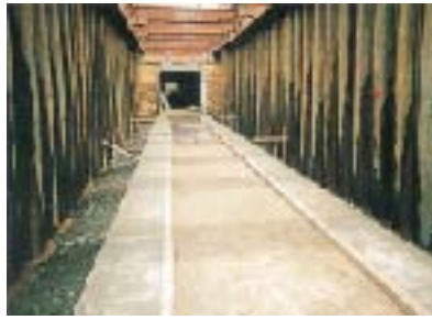
2 増しコン打設
