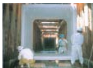
多段切梁区間の施工
