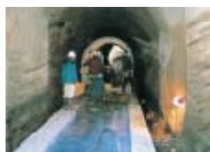
既設トンネル水路改修
