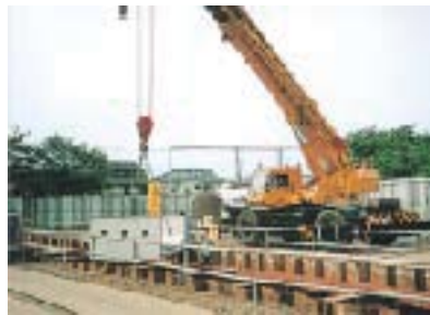
5 クレーン据付工(空伏)
