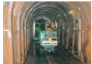
長距離・連結施工(ゴムクローラタンク)
