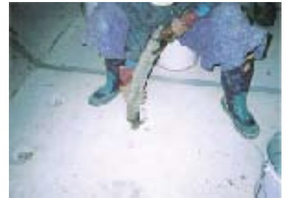
6 底板モルタル充填工
