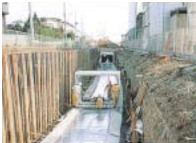
4 エアークャスター据付工
