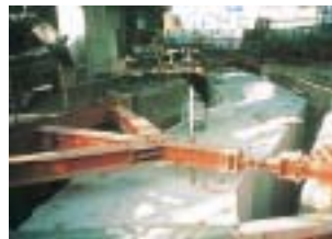
S字区間施工状況
