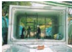
二分組立施工
