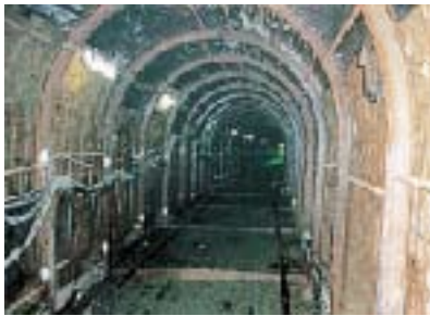
1 基礎埋設鋼材設置工
