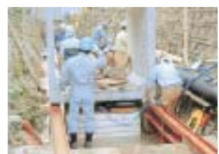
落差工部の施工
