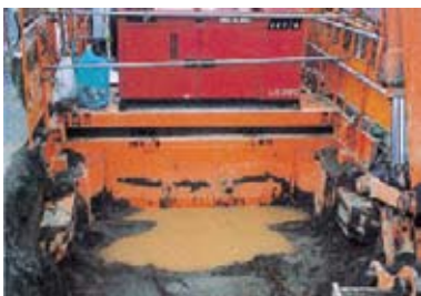
フロント部掘削状況
