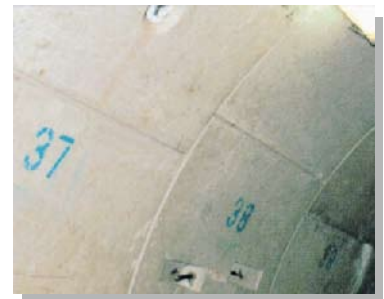
P&PCセグメント (継手金物がない)
