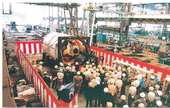
シールド機内でのPC鋼材の挿入・緊張・定張の作業性や ボルトレスによる組立施工性・精度を確認
