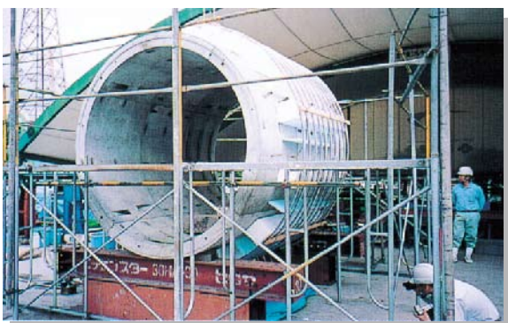
ノンブリージング粘性型グラウト材を用いて 片押し注入で完全に充填できることを確認
