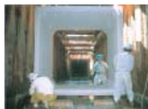
多段切梁区間の施工
