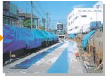
3 滑走面養生工
