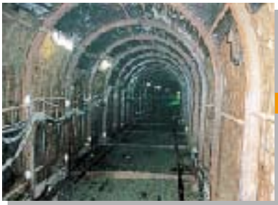
1 基礎埋設鋼材設置工
