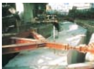
S字区間施工状況
