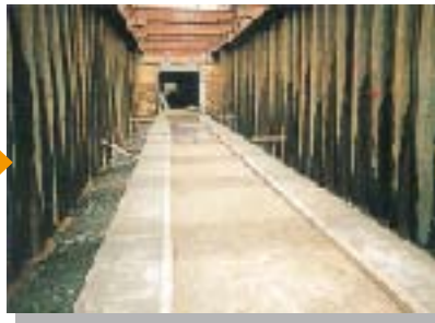
2 増しコン打設
