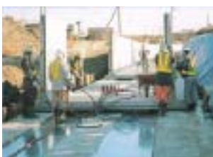
U型水路の施工
