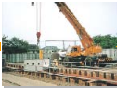
5 クレーン据付工(空伏)
