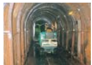
長距離・連結施工(ゴムクローラダンプ)
