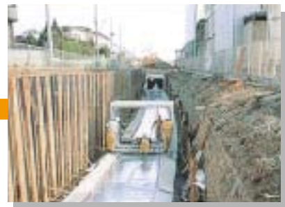
4 エアークャスター据付工
