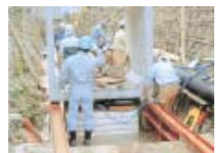
落差部の施工
