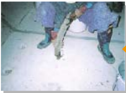
6 底板モルタル充填工
