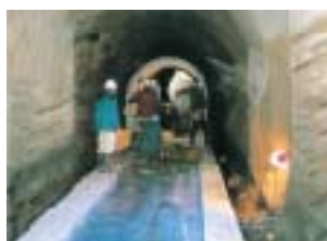
既設トンネル水路改修
