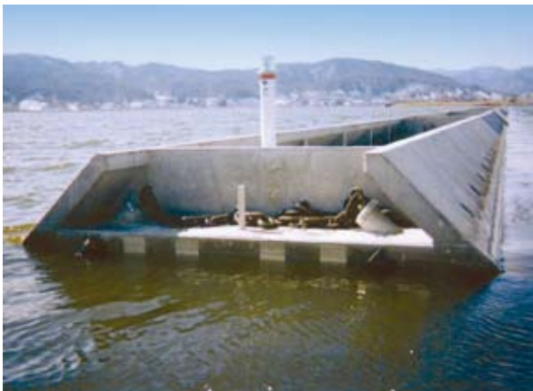
長野県の諏訪湖に湖畔の渚の浸食防止、及び水質浄化を目的として設置された浮体式防波堤です。
